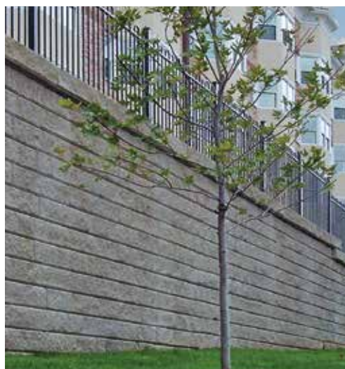
Intégration de clôtures directement au-dessus du mur.
