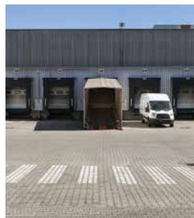
Quais de chargement
